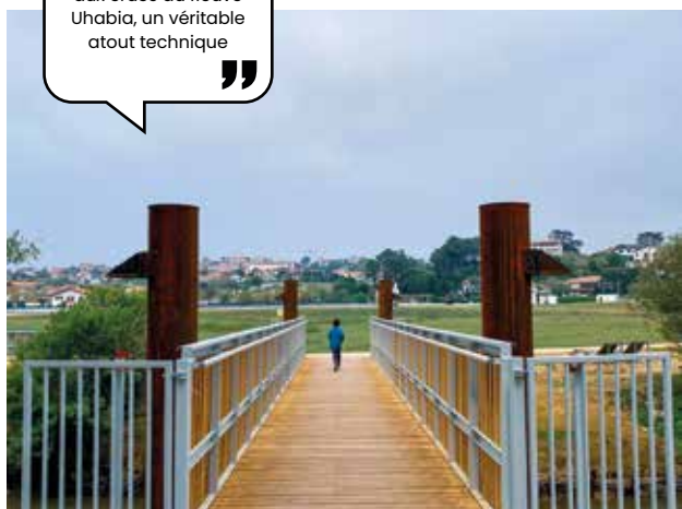
NOUVELLE PASSERELLE UR ONEA
