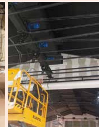
Montage des perches octobre 24
