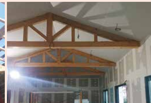
Extension faux plafonds septembre 24
