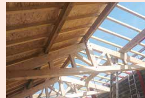
La charpente extension arrive juin 24
