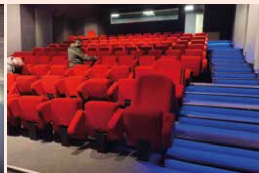
Pose des anciens sièges sur les nouveaux gradins janv. 24
