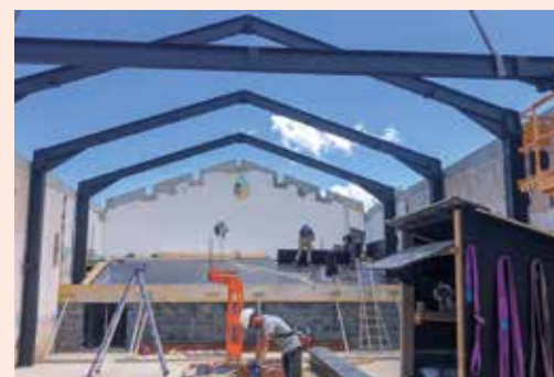
La charpente repousse avril 24
