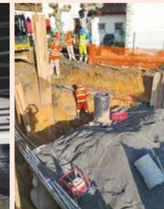
Bassin de rétention, gestion des eaux novembre 24
