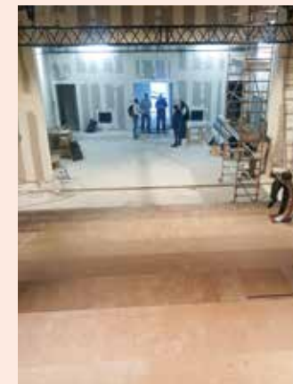
Pose des gradins octobre 24
