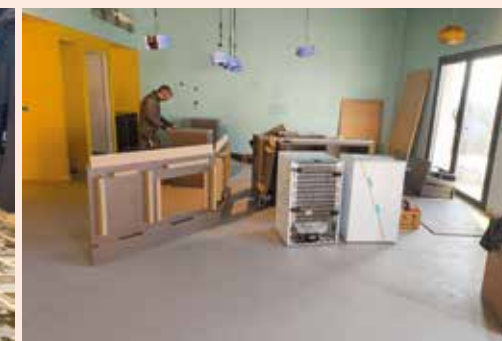
Montage du bar janvier 25
