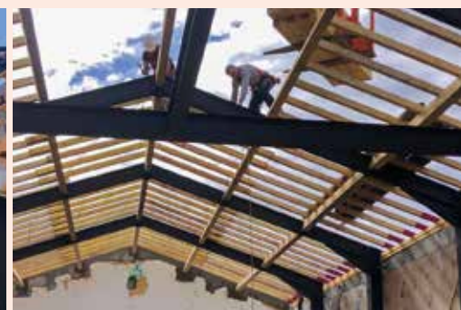
Pose charpente théâtre mai 24
